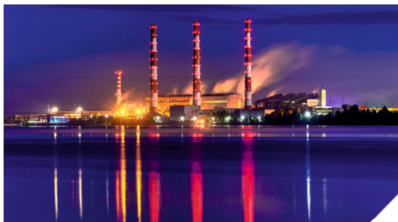
Среднеуральская ГРЭС, филиал ПАО «Энел Россия» Создание системы автоматизированного управления горелками котлоагрегатов энергоблоков № 9 и 11.
