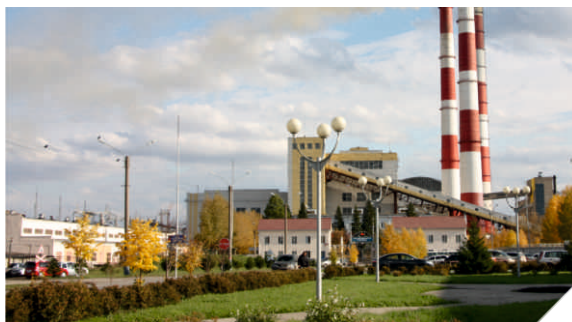
Назаровская ГЭС Оснащение четырех сбросных водоводов сечением 4000*4000 мм приборами учета.
