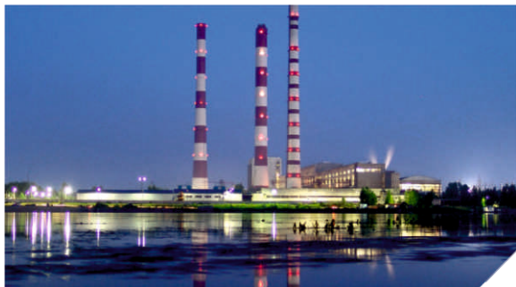
Костромская ГЭС, филиал АО «ИНТЕР РАО-Электрогенерация» Внедрение автоматизированной системы коммерческого учета технической воды на циркуляционных водоводах энергоблоков №1-9 Ду 1800-3000 мм с внесением системы в Государственный реестр СИ.
