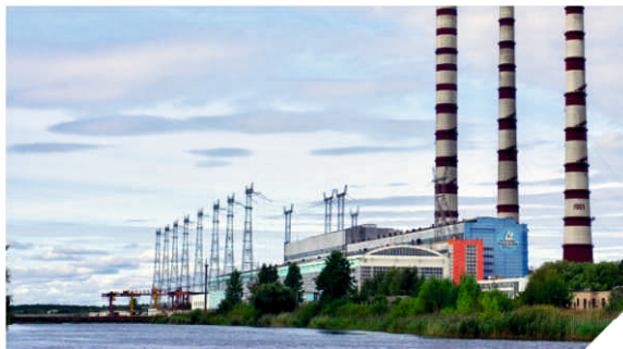
Пермская ГЭС, филиал АО «ИНТЕР РАО-Электрогенерация» Учет расхода воды в сбросном самотечном канале шириной 20 м / учет циркуляционной воды шести трубопроводов Ду 2400 мм / учет тепловой энергии на двух трубопроводах / учет ливневых стоков с внесением систем в Государственный реестр СИ.
