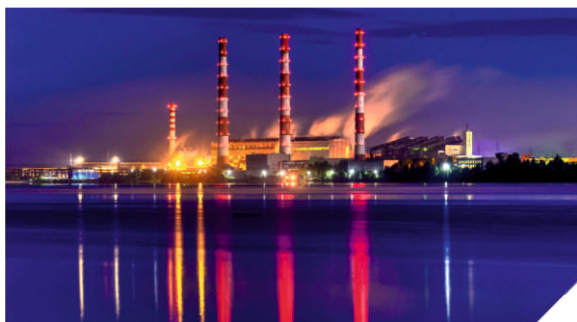
Среднеуральская ГРЭС, филиал ПАО «Энел Россия» Комплекс работ по капитальному, текущему ремонту и техническому обслуживанию сетей освещения кабельных линий, обслуживание с 2014 года, 20 человек
