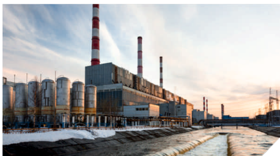
Сургутская ГРЭС-2, филиал ПАО «Юнипро» ТО и Р двух энергоблоков ПГУ-400 МВт, обслуживание с 2012 г., 17 человек.
