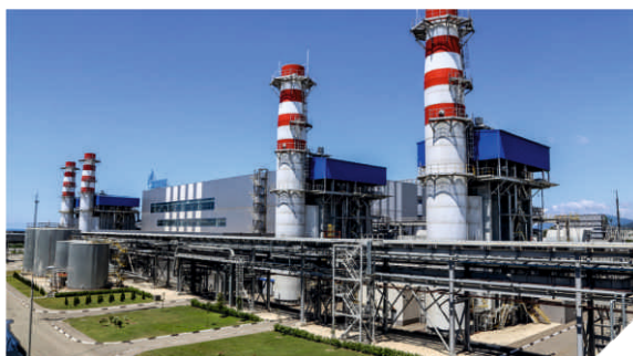
Адлерская ТЭС, филиал ПАО «ОГК-2» ТО и Р приборов автоматического химического контроля двух энергоблоков ПГУ-180 МВт, обслуживание с 2015 года, 7 человек
