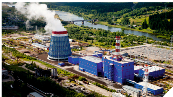
Яйвинская ГРЭС, филиал ПАО «Юнипро» ТО и Р КИПиА энергоблока ПГУ-400 МВт, четырех энергоблоков 150 МВт, обслуживание с 2013 года, 29 человек
