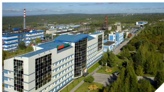
ПАО «Метафракс» Техническое обслуживание автоматизированной системы коммерческого учета энергоресурсов.
