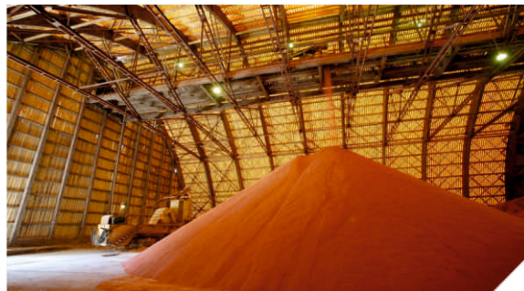
ПАО «Уралкалий» Создание автоматизированной системы учета электроэнергии на Березниковских калийных производственных рудоуправлениях. Модернизация системы технического учета электроэнергии на БКПРУ-4.
