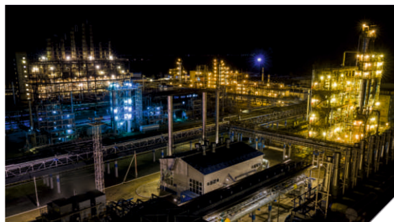
АО «Уралоргсинтез» Монтаж и наладка автоматизированной системы технического учета энергоресурсов / проектирование автоматизированной системы технического учета материальных потоков.
